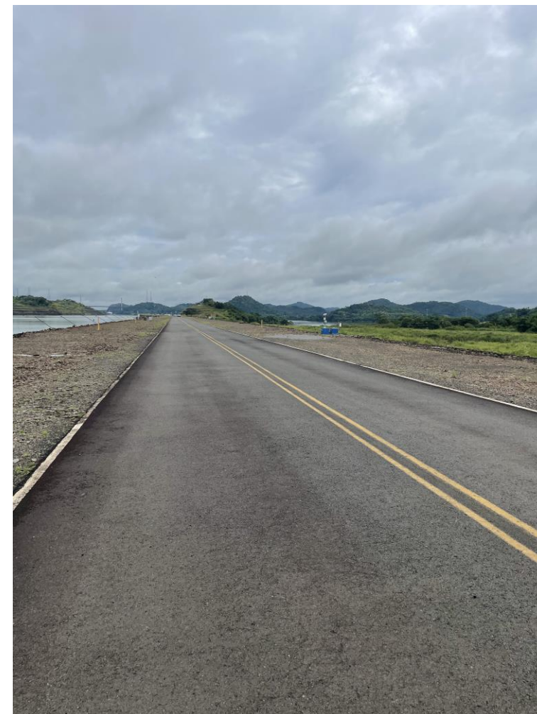
Vista Norte, calzada
