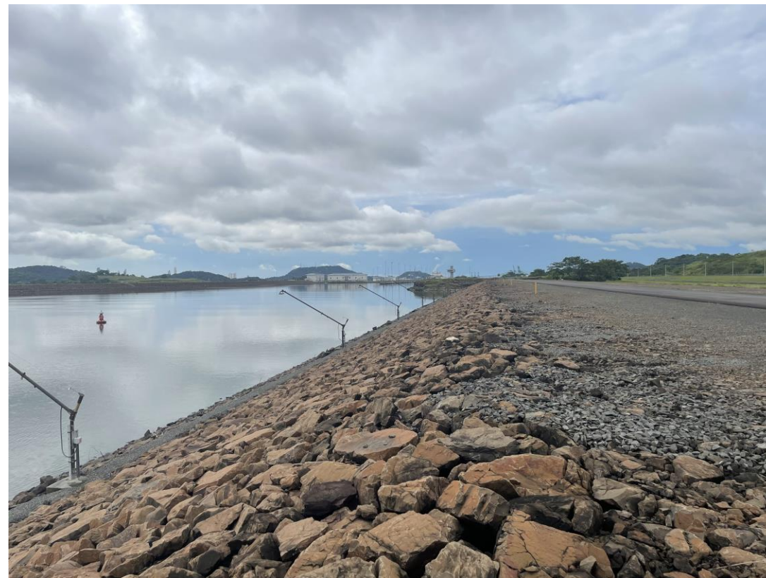
Vista sur, lado este
