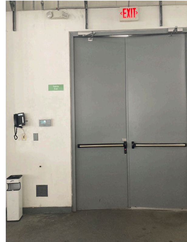
Salida de emergencia despejada
