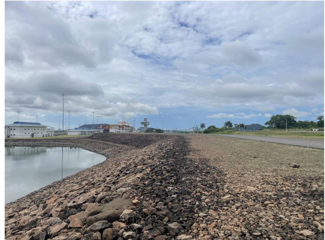
Vista sur, lado este
