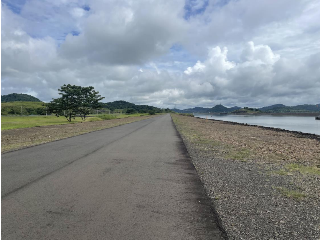
Vista norte, calzada
